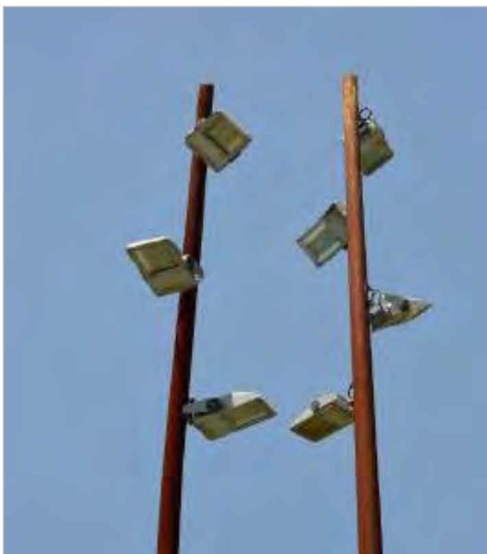
Instalación en columnas decorativas
