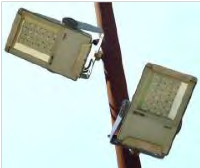
La fijación por lira permite cualquier orientación
