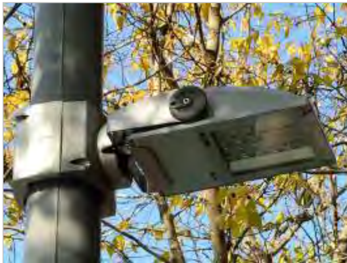
Posibilidad de ampliación en columnas existentes
